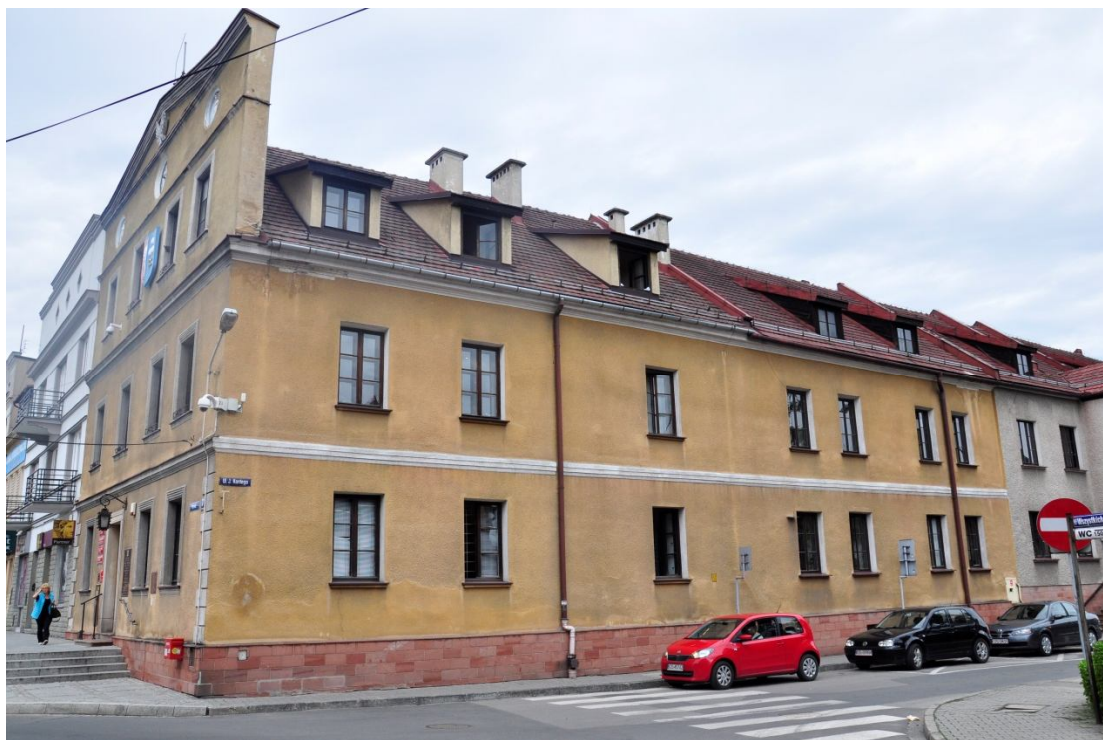
Fot. 1. Elewacja południowo-wschodnia budynku Urzędu Gminy Kęty. Stan przed realizacją projektu.
