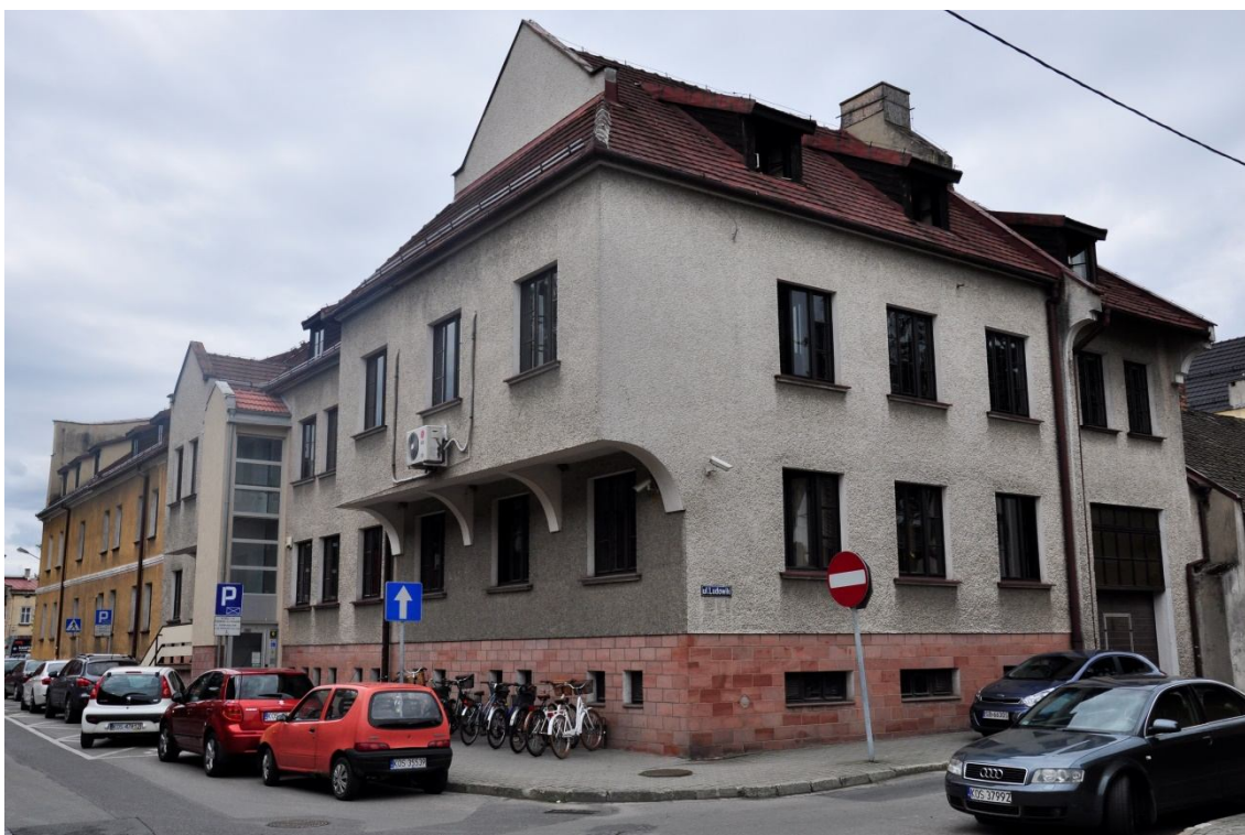
Fot. 2. Elewacja północno-wschodnia budynku Urzędu Gminy Kęty. Stan przed realizacją projektu.
